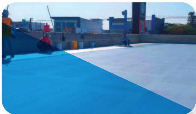
ระบบกันซึม
