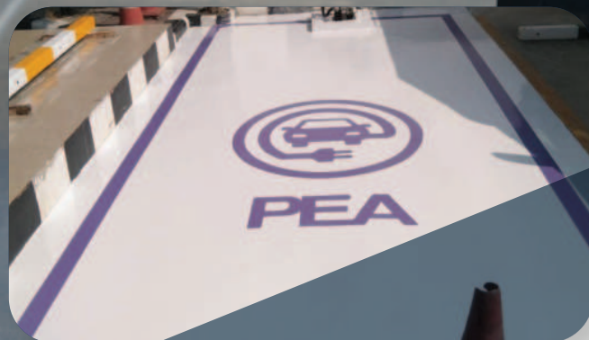
งานพื้นลานจอดรถ
