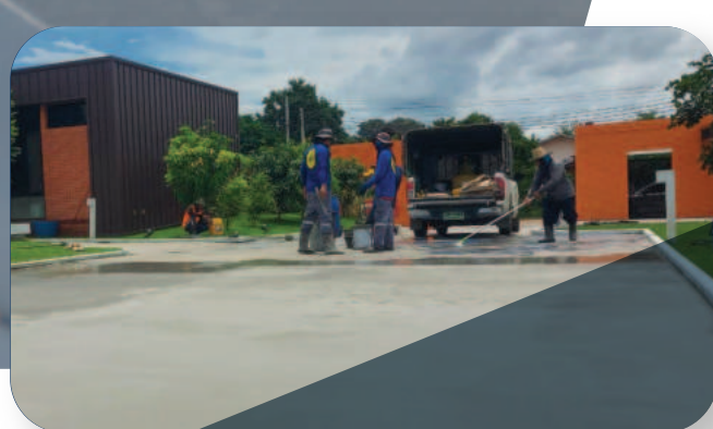
งานซ่อมแซมพื้นผิวถนนและ ปรับแต่งลานจอดรถ
